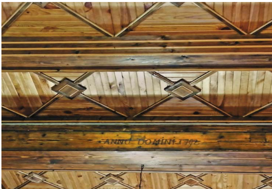
Cerkiew w Ustianowej, belka stropowa z wyciętą datą budowy – 1792
