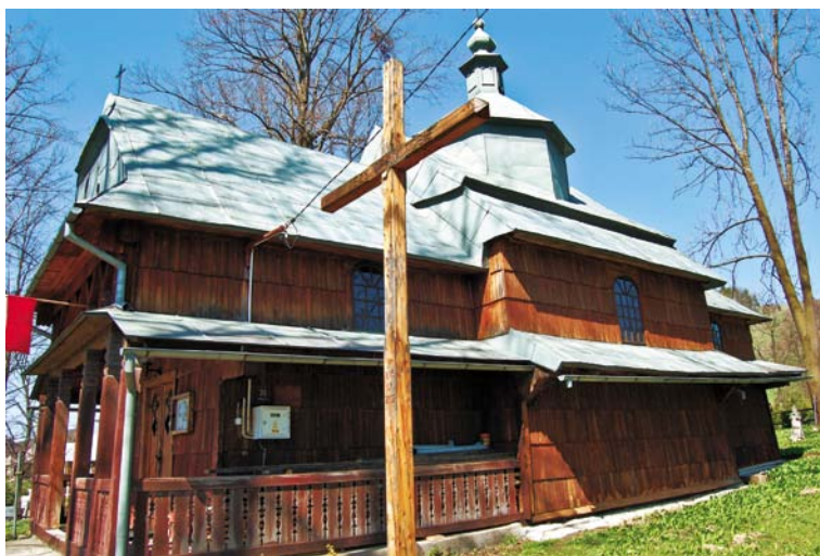
Cerkiew w Rabem, w której formy tradycyjnej architektury greckokatolickiej funkcjonują obok tych zaczerpniętych z rozwiązaniami z architektury łańciskiej. Fot. Krzysztof Zieliński
