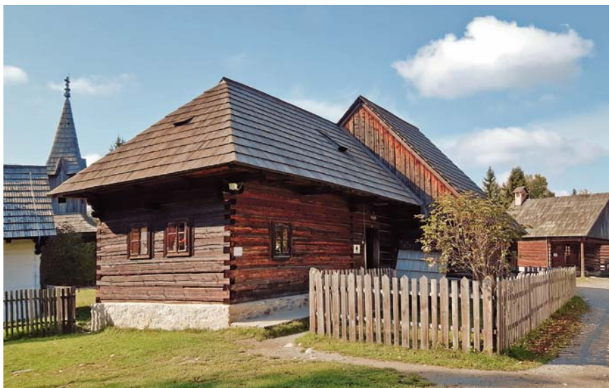
Typowa zabudowa tradycyjnej architektury w skansenie w Pribylinie
