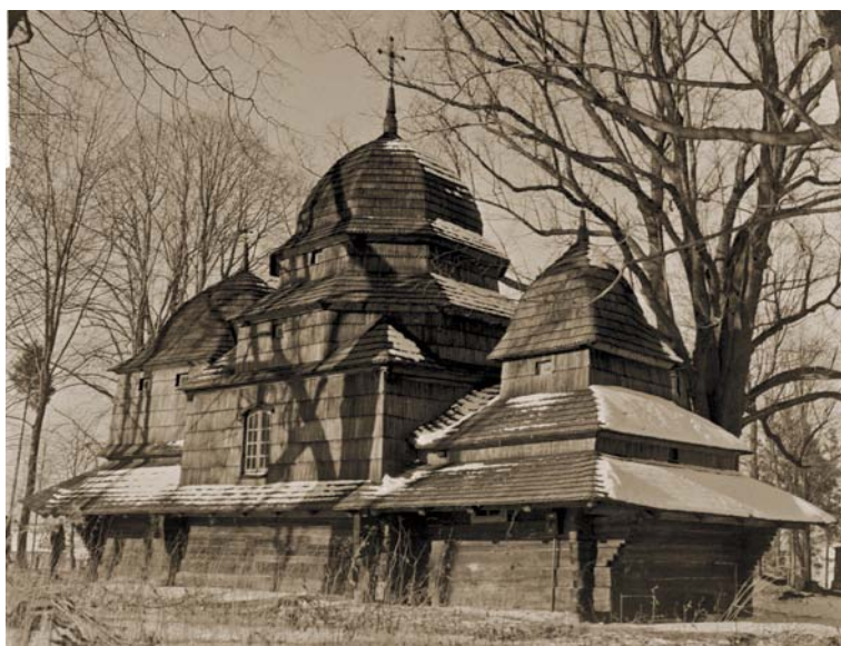
Równia, cerkiew, ostatnie dni grudnia w 1976 r. (fot. S. Kryciński)
