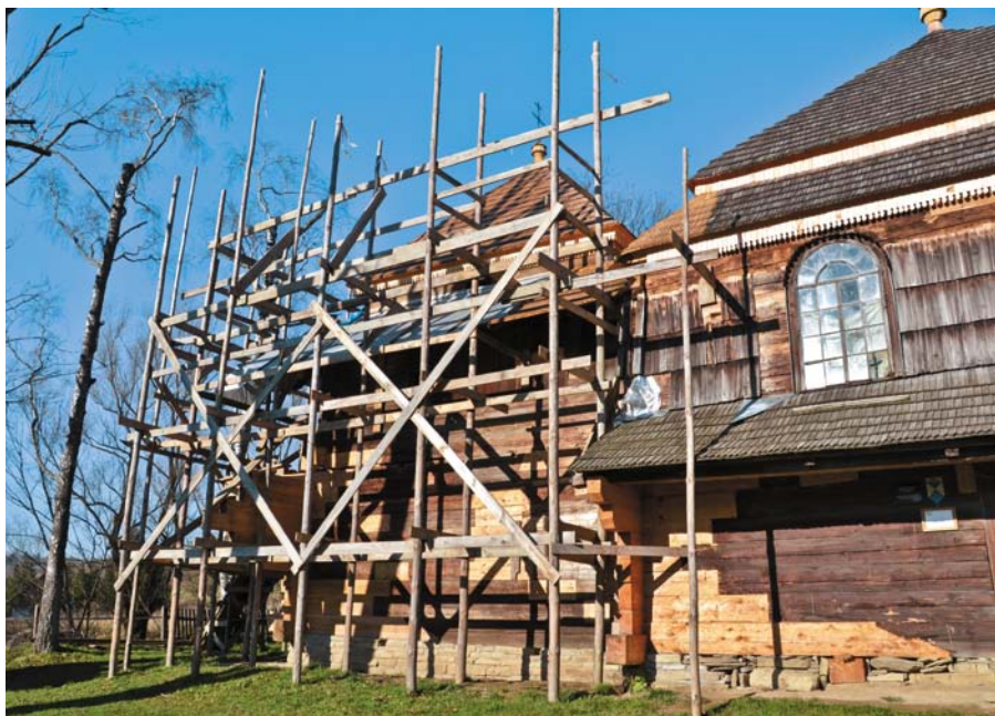
Liskowate, prace remontowe w 2015 r.
